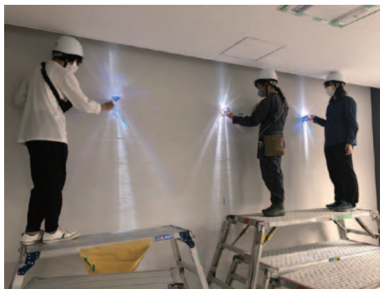
Figs.29 現場設置、切子位置決めの様子
