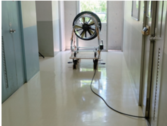
図 6 送風機を設置した様子
