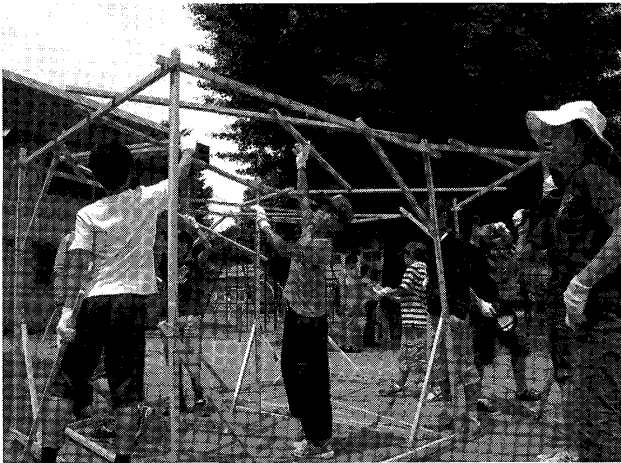
図 31 何度もやり直して屋根の架構をつくる
