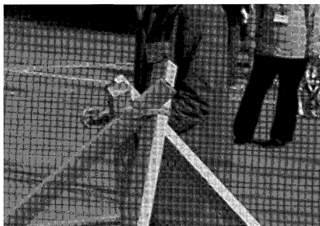
図 5 ゴムバンドによる角材の固定方法
